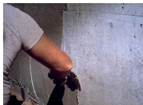
Zaprawę PCI Barraseal ® 2K Objekt można nanosić pędzlem lub przy pomocy urządzenia natryskowego
