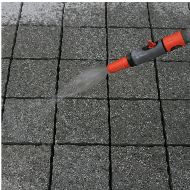
Przed aplikacją PCI Pavifix® 1K Extra powierzchnię kostki brukowej należy obficie zwilżyć wodą.
