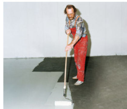
PCI Apokor ® W to wysokiej jakości powłoka epoksydowa odporna na lekkie i średnie obciążenia mechaniczne.
