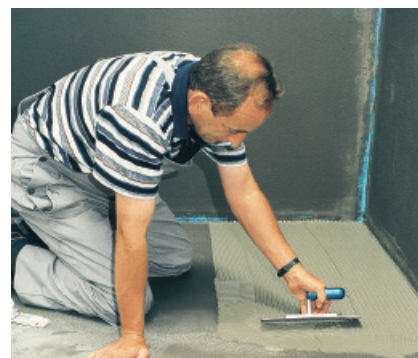
Dodatek PCI Lastoflex ® podnosi elastyczność cementowych zapraw klejących PCI, zwiększając ich zdolność do przenoszenia naprężeń.
