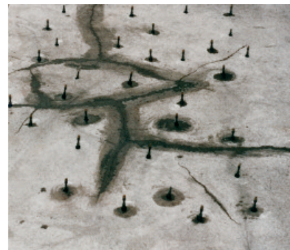
Przyklejanie do podłoża betonowego odspojonych jastrychów cementowych przy użyciu PCI Apogel ® -Schnell.
