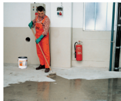
Impregnowanie jastrychu cementowego
