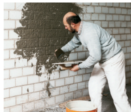
Obrzutka sporządzona przy użyciu PCI Emulsion zwiększa przyczepność tynku.
