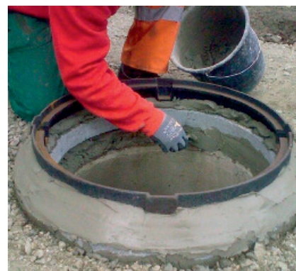
Osadzenie przejścia rurowego za pomocą PCI Polyfix® plus.
