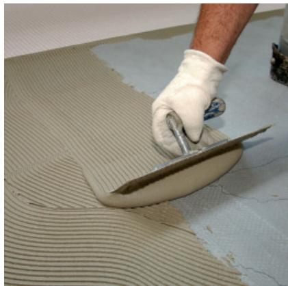
Na świeżo nałożonej warstwie zaprawy klejącej...
