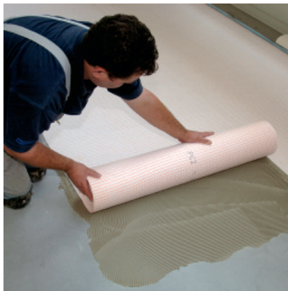
...ułożyć wycięte odcinki maty PCI Pecilastic®...
