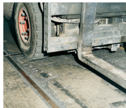
PCI Elritan ® 140 doskonale nadaje się do wykonywania dylatacji w posadzkach przemysłowych.
