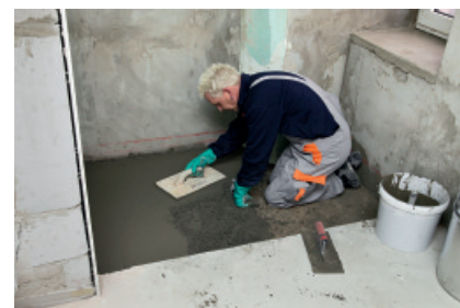
PCI Novoment ® M1 plus jest gotową zaprawą do jastrychów szybko wiążących - stanowi ekonomiczne i praktyczne rozwiązanie przy wykonywaniu nawierzchni, które muszą być szybko użytkowane.
