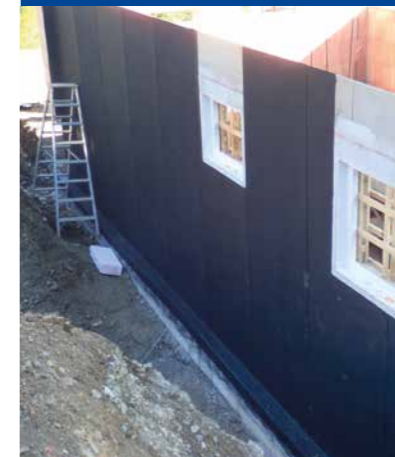
Uszczelnianie obiektów budowlanych
