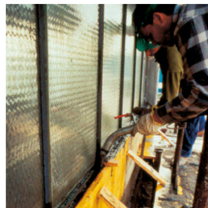
PCI Nanocret ® R4 Fluid nadaje się do powierzchniowych napraw metodą zalewania w szalunku.
