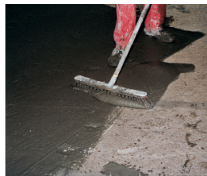
Natychmiast po wtarceniu PCI Repahaft ® w uprzednio przygotowane podłoże nanosi się metodą „mokro na mokro” zaprawy jastrychowe.
