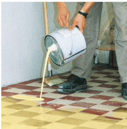
Dokładnie wstrząsnąć lub przemieszać PCI Gisogrund® 303 i wylać na podłoże.
