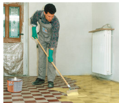
PCI Gisogrund ® 303 zapewnia doskonałą przyczepność nowych okładzin do starych płytek.
