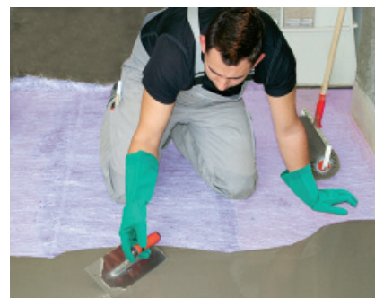
Wylewkę samopoziomującą o grubości min. 5 mm nanosi się na uprzednio zagruntowane podłoże i rozłożoną matę wzmacniającą PCI Armiermatte ® GFM.
