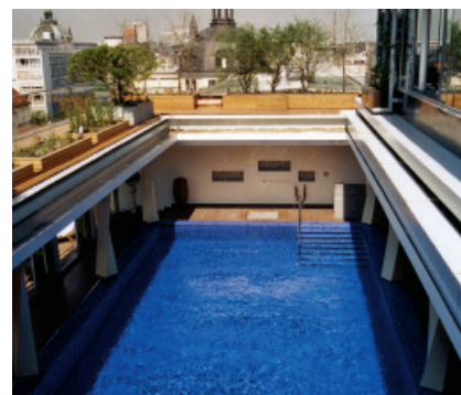
Okładzina płytkowa w nieszce basenowej wyklejona na PCI Collastic ® .
