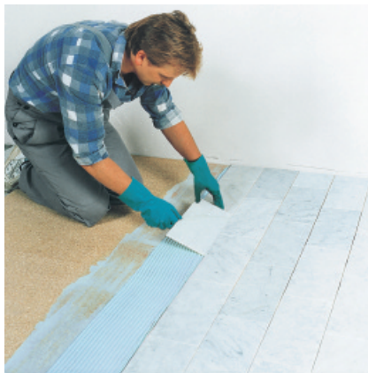
Za pomocą PCI Collastic® można wyklejać również marmur na podłożach drewnopochodnych.
