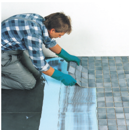
Płytki układa się na nałożonej grzebień warstwie kleju i wyrównuje.
