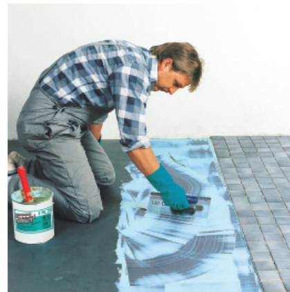
Także blachy stalowe nadają się jako podłoże do wyklejania okładzin za pomocą PCI Collastic®.
