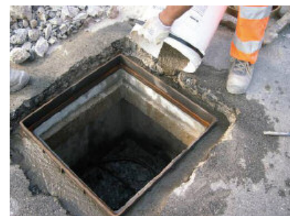
Wypełnienie przestrzeni wokół obramowania wjazdu studzienki za pomocą PCI Repafast® Fluid.
