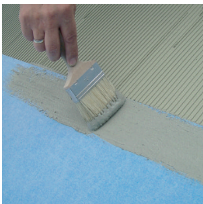
Styki maty skleić izolacją mineralną PCI Seccoral®
