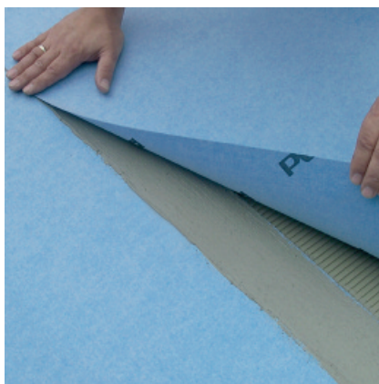
W ramach czasu otwartego zaprawy klejącej przykleić kolejny odcinek maty.
