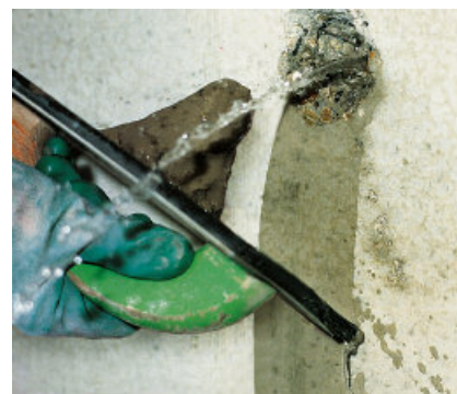
Błyskawiczna zaprawa PCI Polyfix ® 30 Sek. umożliwia natychmiastowe uszczelnienie przecieków wody.
