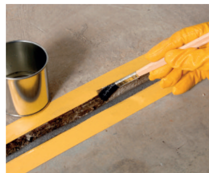
PCI Elastoprimer polepsza przyczepność uszczelniaczy PCI do podłoża.
