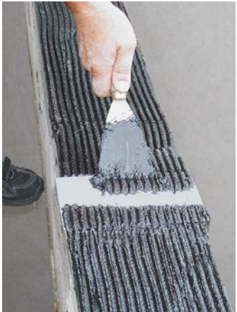
Nałożenie Enkolit na blachę kompensacyjną
