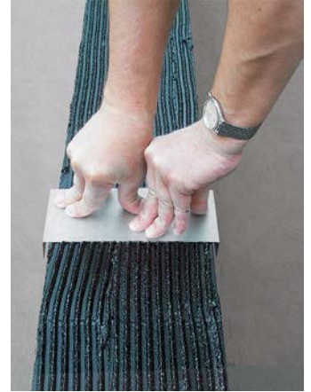
Wklejenie blachy kompensacyjnej
