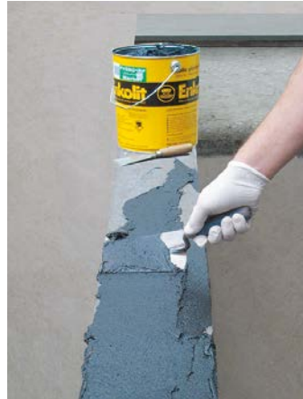
Nakładanie Enkolit kielnią lub pacą
