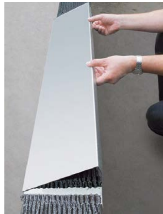
Umieszczenie obróbki blacharskiej
