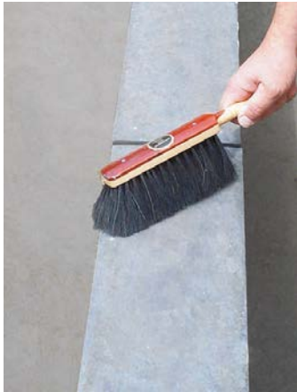
Oczyszczenie podłoża
