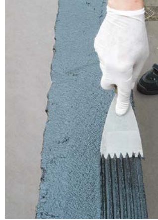
Rozprowadzenie Enkolit szpachlą zębatą
