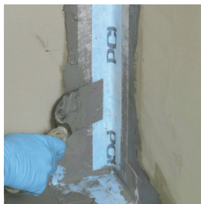
W 1. warstwie malowanej wkleić taśmy...
