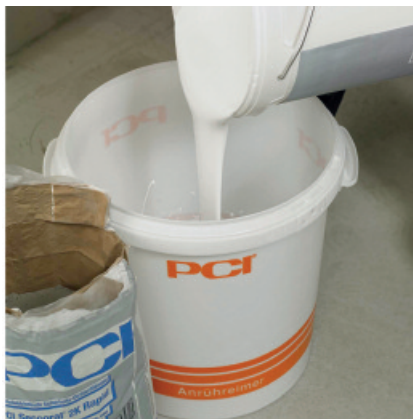
Do czystego naczynia zarobowego wlać składnik płynny
