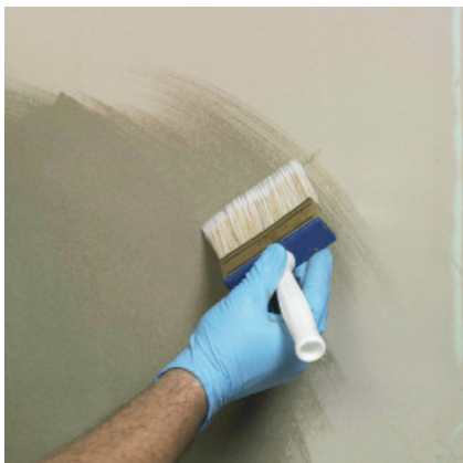
Zwilżyć podłoże do stanu matowo-wilgotnego
