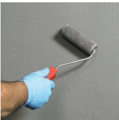
Wykonać 1. warstwę (malowaną) na pozostałej powierzchni podłoża.
