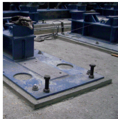
PCI Repaflow® nadaje się do podlewek precyzyjnych, co pozytywnie wpływa na żywotność maszyn.
