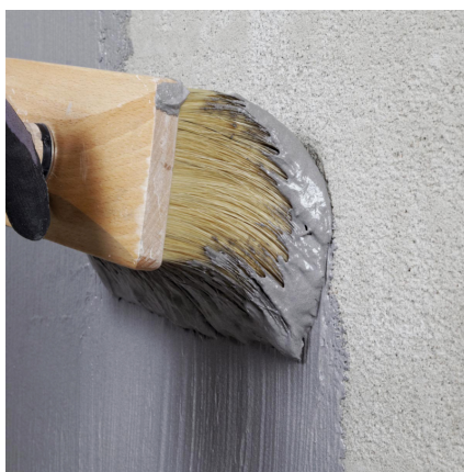
Warstwa kontaktowa nakładana pędzlem.
