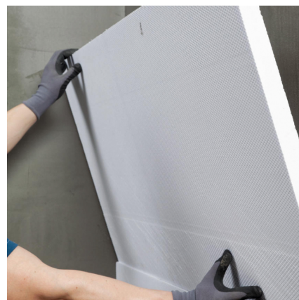
Przy zastosowaniu PCI Barraseal® Turbo można na wyschniętej powłoce kleić płyty drenażowe i izolacyjne.
