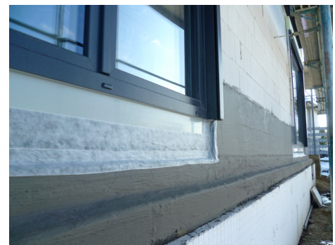
Uszczelnienie stolarki okiennej przy zastosowaniu PCI Barraseal ® Turbo oraz taśm uszczelniających PCI Pectape ® .
