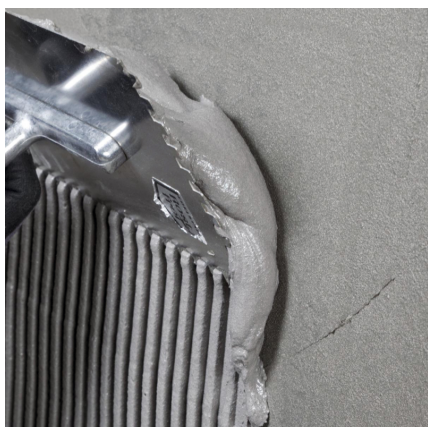
PCI Barraseal® Turbo należy nakładać w minimum dwóch warstwach. W celu kontroli grubości warstwy materiał można nałożyć pacą zębatą, a następnie wygładzić.
