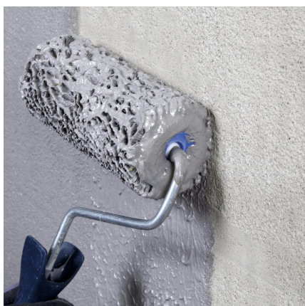
Warstwa kontaktowa nakładana wałkiem
