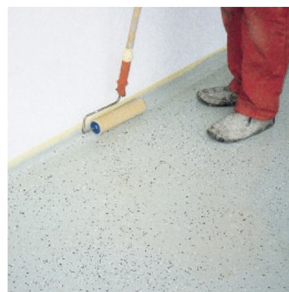
Pierwszą, barwną warstwę powłoki można w stanie świeżym posypać wiórkami (chipsami), a następnie nanieść drugą, bezbarwną warstwę.
