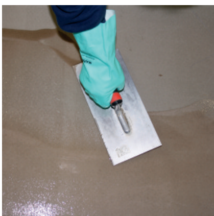
Przespachlowanie zaprawą na bazie PCI PUR-Grund chroni powłokę przed powstawaniem pęcherzy i zapewnia jej doskonałą przyczepność do podłoża.
