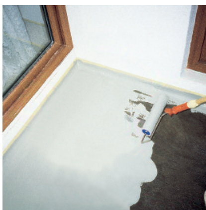
Powłoka daje się łatwo aplikować wałkiem z krótkim włosiem.
