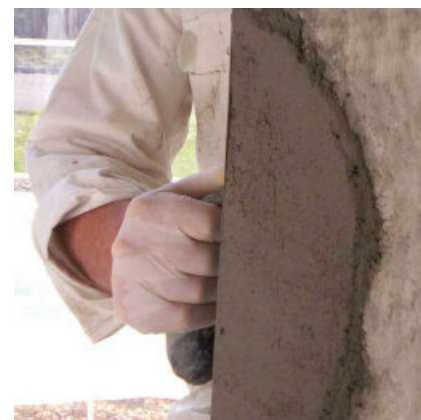
Naprawa naroży to tylko jedna z możliwości zastosowania wszechstronnej zaprawy PCI Nanocret® R2.
