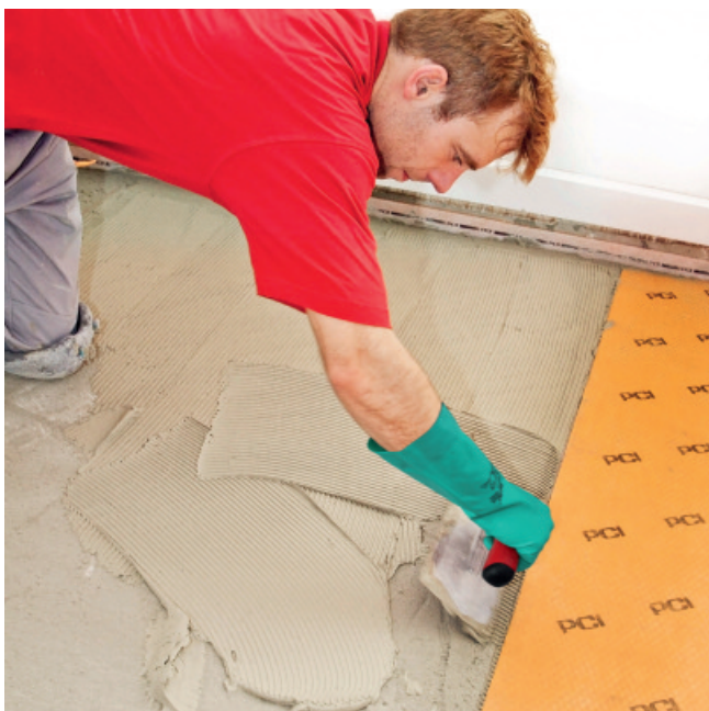
Na przygotowanym podłożu nanieść pacą zębatą warstwę zaprawy klejącej do płytek i przykleić przygotowany odcinek PCI Pecilastic® U.
