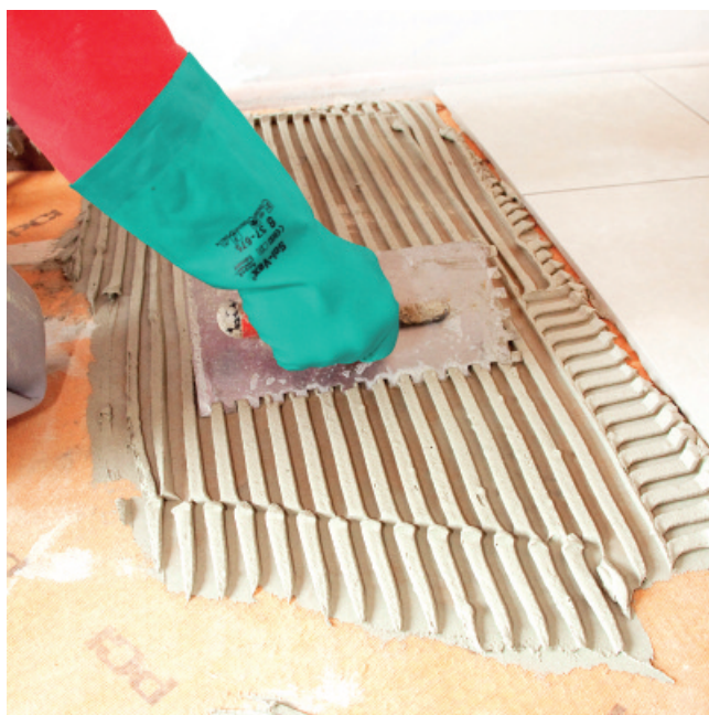
Stosując elastyczną zaprawę klejącą przykleić okładzinę płytkową.
