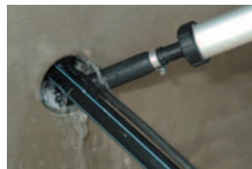
... Kabeldurchführung wird mit ...
