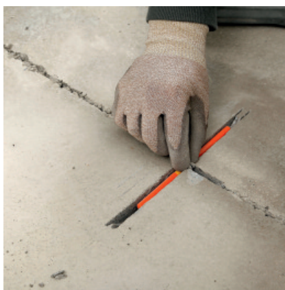
Włożyć w bruzdy dyble PCI Apogel® Dübel.
