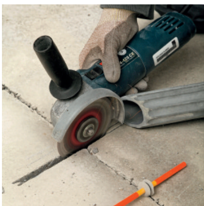
Naciąć jastrych co ok. 30 - 40 cm prostopadłe do osi dylatacji.
