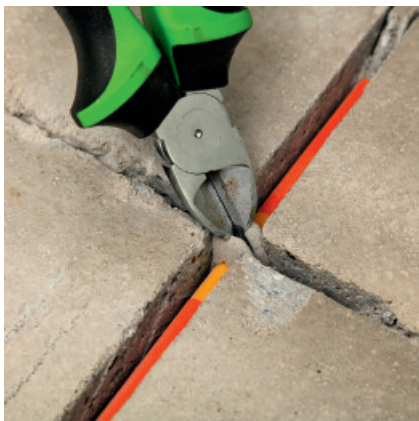
Przeciąć i usunąć opaski ściskające pierścienie piankowe na dyblach.
