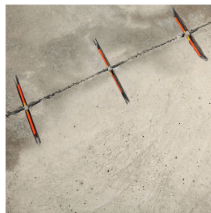
Tylko 3 dyble wystarczają do zabezpieczenia dylatacji w progu drzwiowym.
