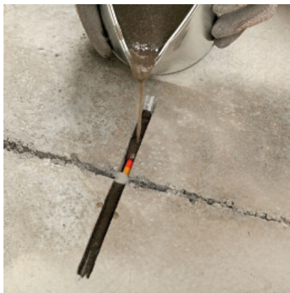
Wypełnić wnętrza bruzd wokół dybli mieszanką PCI Apogel® F i PCI Quarzsand 0,3 - 0,8.
