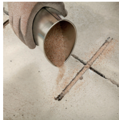
Posypać wypełnienia bruzd z wierzchu piaskiem PCI Quarzsand 0,3 - 0,8.
