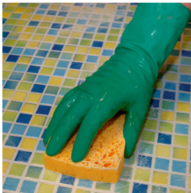
Zmywanie mozaiki zaspoinowanej PCI Durapox® NT / PCI Durapox® NT plus.
