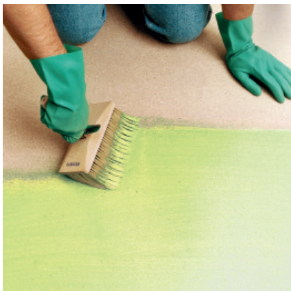
1. Rozprowadzić PCI Wadian® metodą „na krzyż” na podłożu, pokrywając dokładnie całą powierzchnię.
