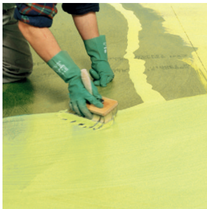
2. Po upływie czasu odpowietrzania, wynoszącego ok. 30 minut, nanieść na całą powierzchnię drugą warstwę.
