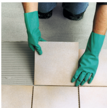
5. Po wyschnięciu uszczelnienia można przy użyciu zaprawy cementowej wykleić okładzinę płytkową.
