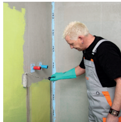
3. Po całkowitym wyschnięciu PCI Wadian® można nanieść na podłoże uszczelnienie dyspersyjne PCI Lastogum®...
