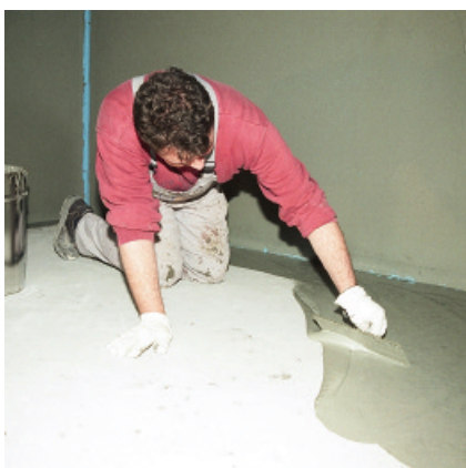
4. ... lub uszczelnienie cementowe PCI Seccoral®.
